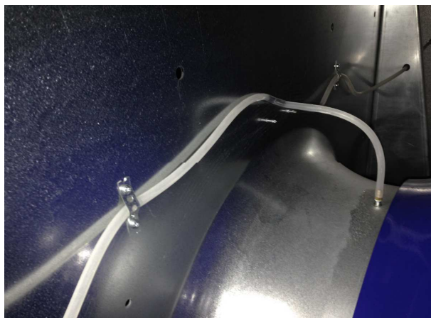
Slanger for måling af differenstryk til opgørelse af SEL-faktor
