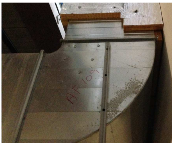
Ledeplader i forbindelse med kritiske bøjninger
