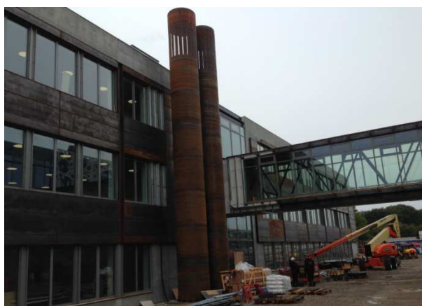
Skorstene for indtag, spalter i top
