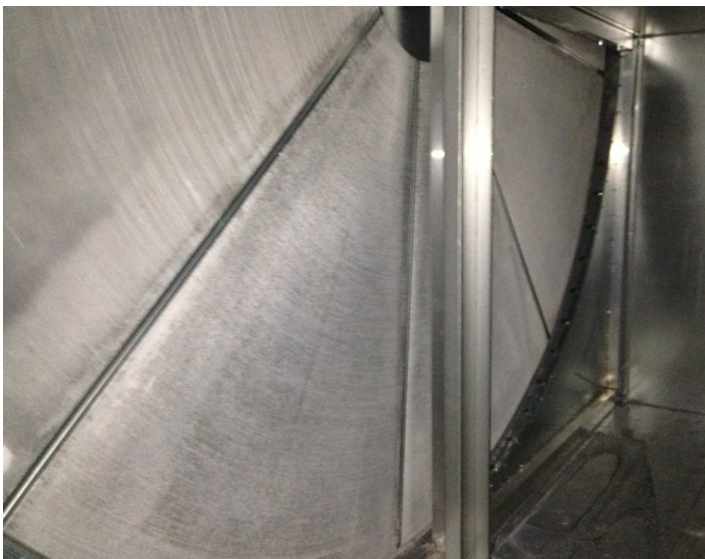
Samme kammer som foranstående billede, men for rotorveksler ses – friskluft opvarmet af rotorveksler
