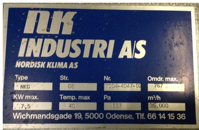
Mærkeplade for indblæsningssektion for ét af de 4 ens aggregater
