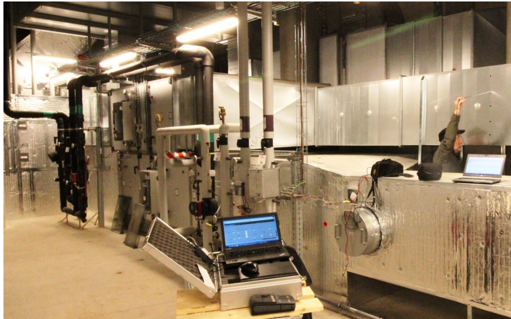
Illustration nr. 3 herover og 4 herunder. Foto fra igangværende performancetest, hvor der udføres stikprøvekontrol mht sammenhæng mellem anlægsopbygning, anlægsbillede, instrumentering, følerøjagtighed og logninger.
