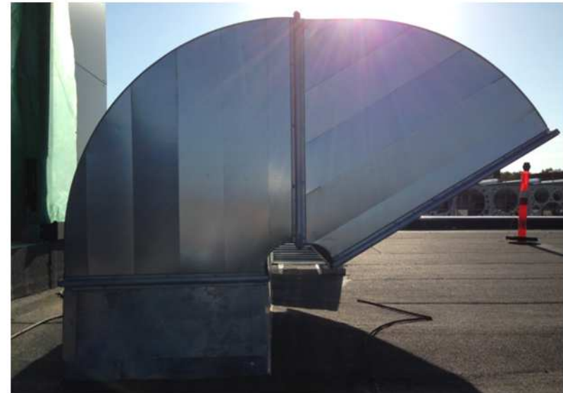
Tværsnitsarealet øges ud mod selve afkastet.
