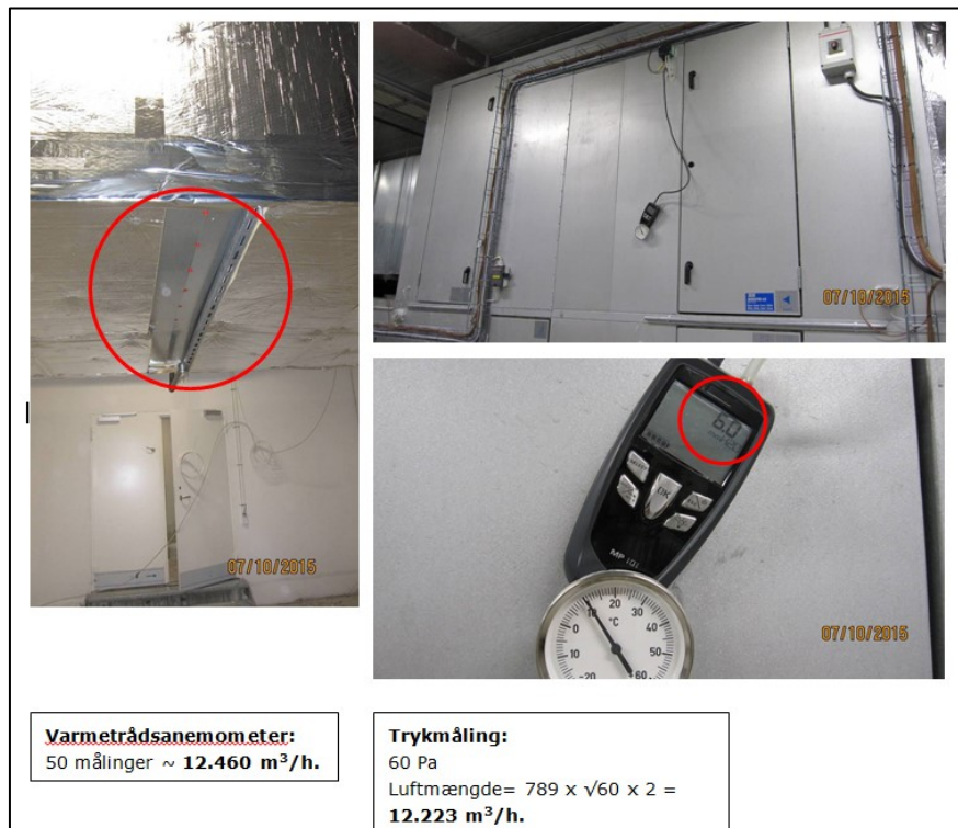
Illustration nr. 4 herover viser et eksempel på hvordan en performancetest er dokumenteret, hvor fotografier dokumenterer testens resultater.
